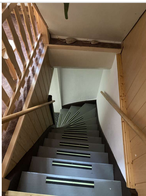
Treppe EG zum OG
